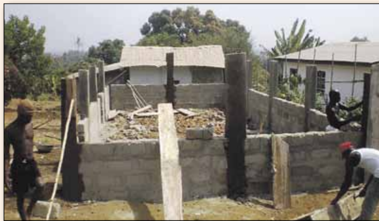
Hönshuset byggs / Kanalaa rakennetaan
